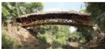
Contrucción comunitaria del puente en Bambú en Matina -Davao -Filipinas - HPFPI - PACSII - ACHR - SABA - MANTAS - UP - UM
